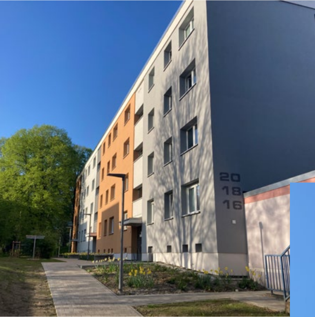
Modernisiertes GWH Quartier im Schelmengraben
