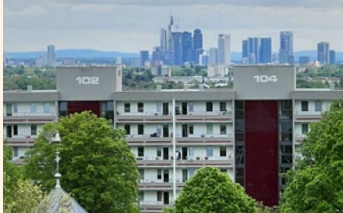
Neue Aufzugsanlage für das BGR-Quartier der GWH
